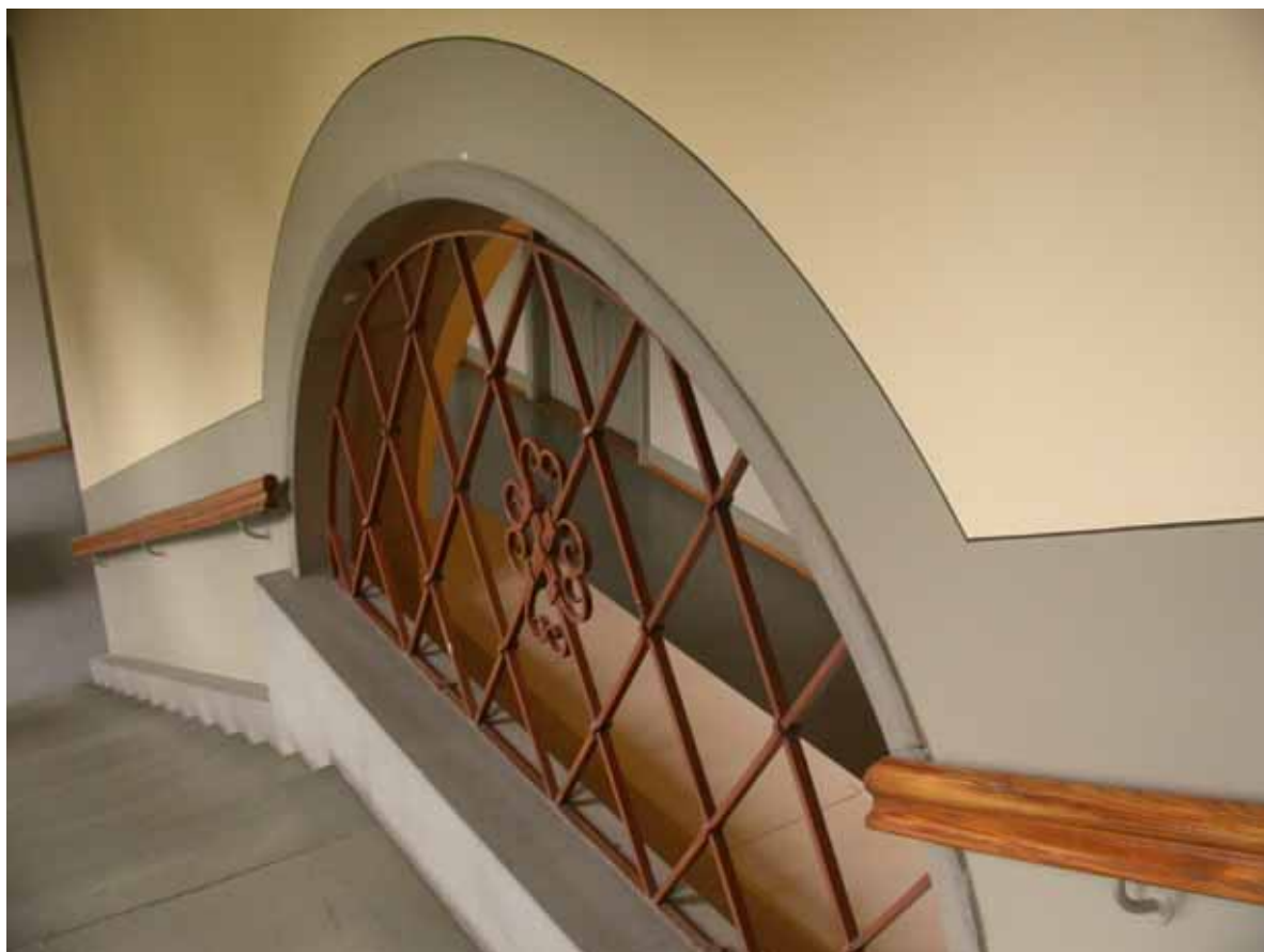
Detail vom Treppenhaus
